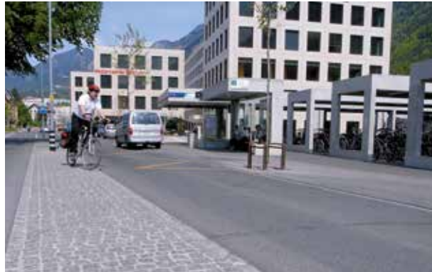
Sichere Zufahrt dank Abbieghilfe und flachen Trottoirrändern.
