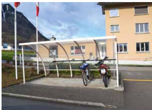
Überdachte Veloparkierung in Beckenried. Das Parkiersystem kann optimiert werden.
