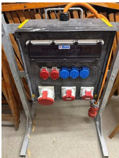
mobiler Elektro-Verteilkasten
