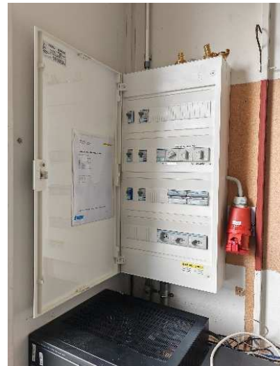
Unterverteilkasten Pavillon innen
