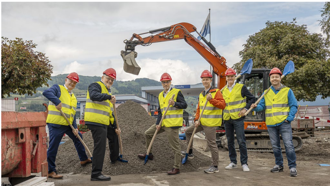
Beim Spatenstich am 26. September 2025 in Buochs vor Ort (v.l.n.r.): Joe Christen, Regierungsrat Kanton Nidwalden, Werner Zimmermann, Gemeindepräsident Buochs, Remo Infanger, Direktor EWN, Matthias Kolb, Geschäftsleitung Anex Ingenieure AG, Adrian Burri, Leiter Geschäftseinheit Wärme EWN, Patrik Dommen, Leiter Bauamt Buochs
