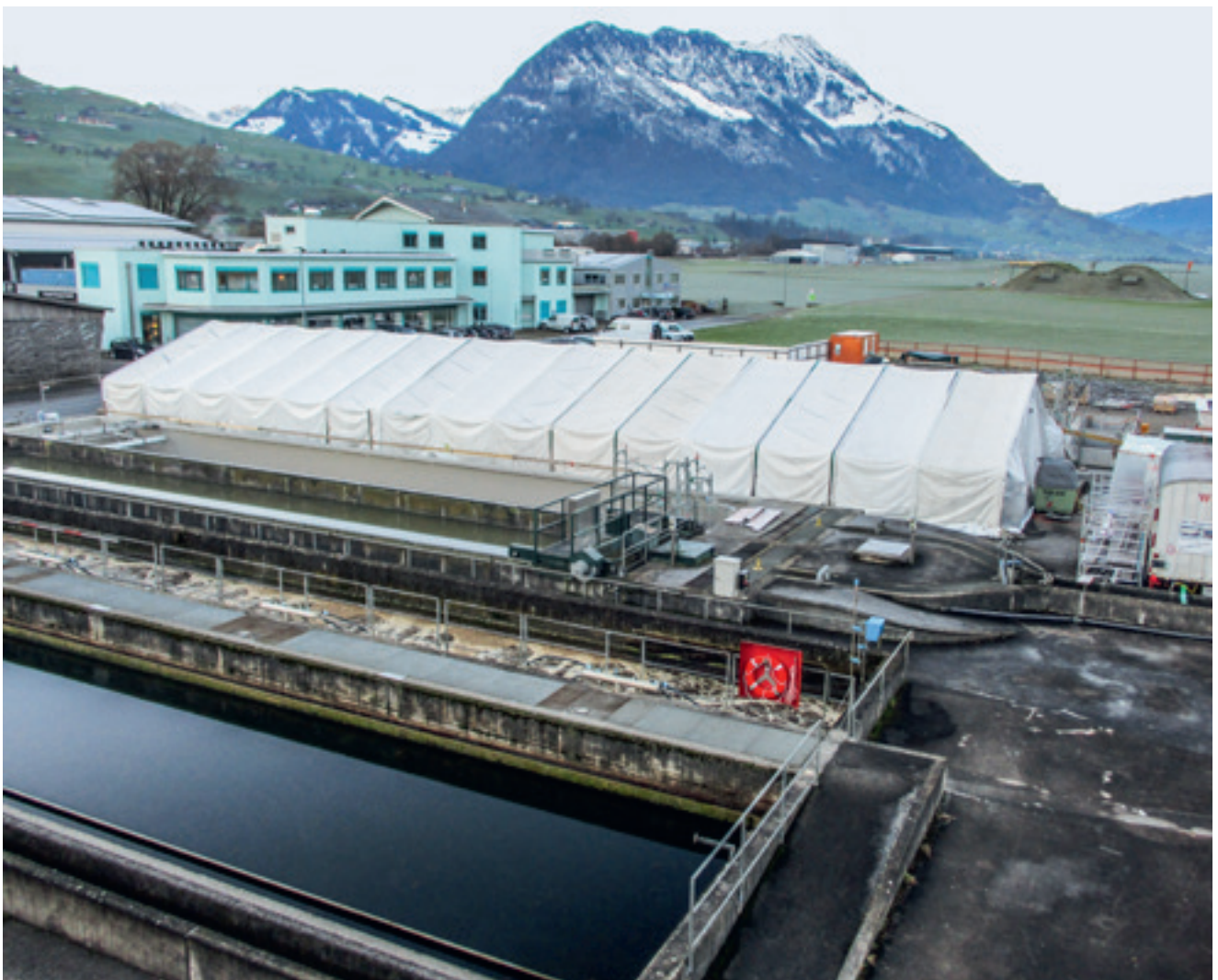
Zeltaufbau für Betonsanierung
