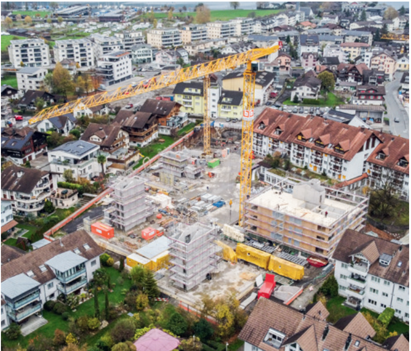
Übersicht STÄDELIHOF, unten rechts wird das Haus fünf aufgerichtet, dahinter das Wohn und Pflegezentrum Stadelipark. Im Uhrzeigersinn stehen die Häuser fünf, vier, drei, zwei, eins (Drohnenaufnahme architekturwerk ag, Sarnen)
