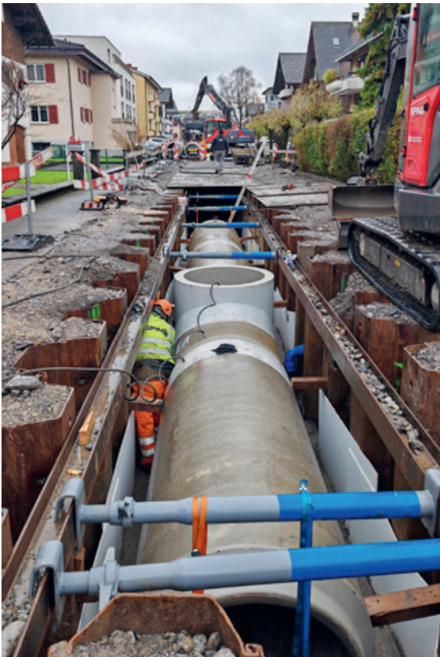
Betonrohre im gespriessten Graben
