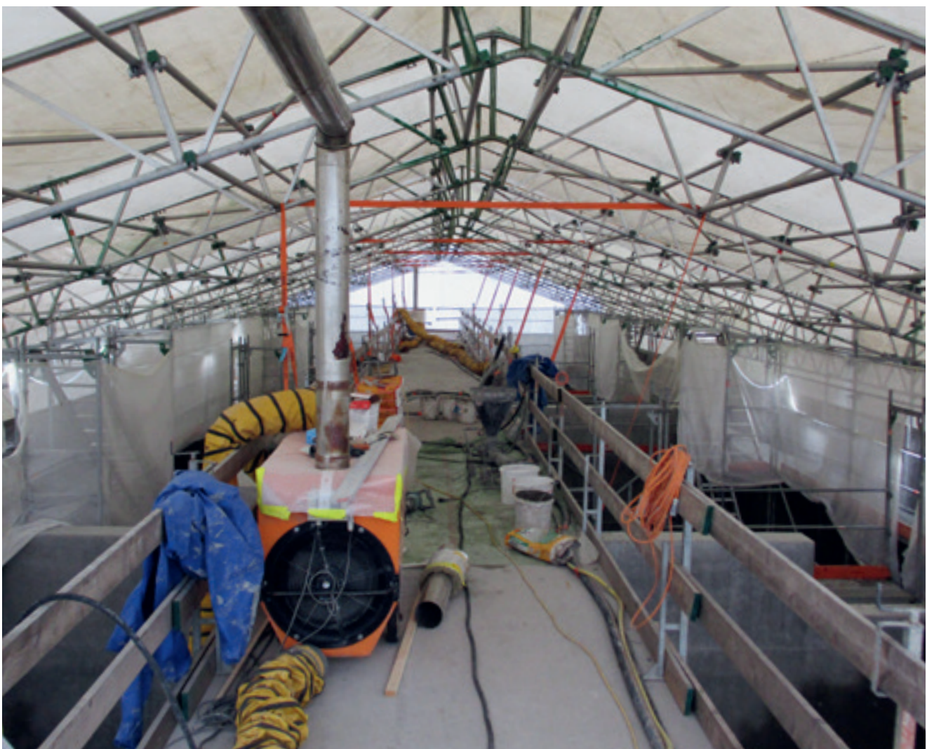
Betonsanierung unter Zeltdach
