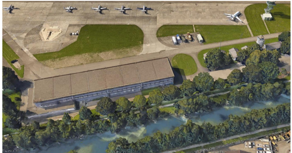
Abbildung 10: Bestehende Gebäude, Blick in Richtung Nordwesten (Quelle: Google Earth)
