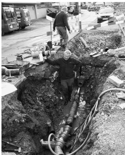
Zimmermann Heizung + Sanitär GmbH, Buochs / Zimmermann Tiefbau AG, Bauunternehmung, Buochs
