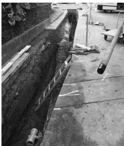
Bircher Sanitäre Anlagen AG, Ennetbürgen / Achermann AG, Bauunternehmung, Buochs
